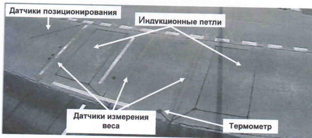
Рис. 6. Пример размещения датчиков на дорожном полотне
